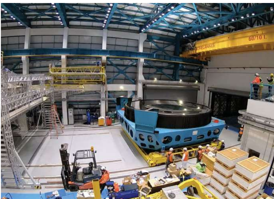
Slika 1: primarno/tercijarno zrcalo na putu s 3. kata zvezdarnice prema teleskopu na 8. katu. Na desnoj strani slike vidi se veliko transportno dizalo. Kratki video instalacije primarnog/tercijarnog zrcala je dostupan kao: https://Rubin.canto.com/b/TUKR1
