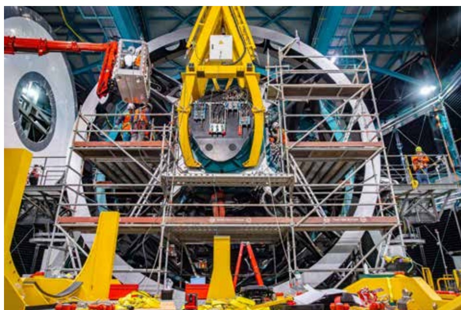
Slika 2: Spajanje LSST kamere sa Simonyi teleskopom. Velikim kliještima (žuti prsten s trokutom na vrhu), kamera od 3,000 kg je podignuta do visine otvora u centru sekundarnog zrcala i pažljivo umetnuta s tolerancijom manjom od milimetra.
